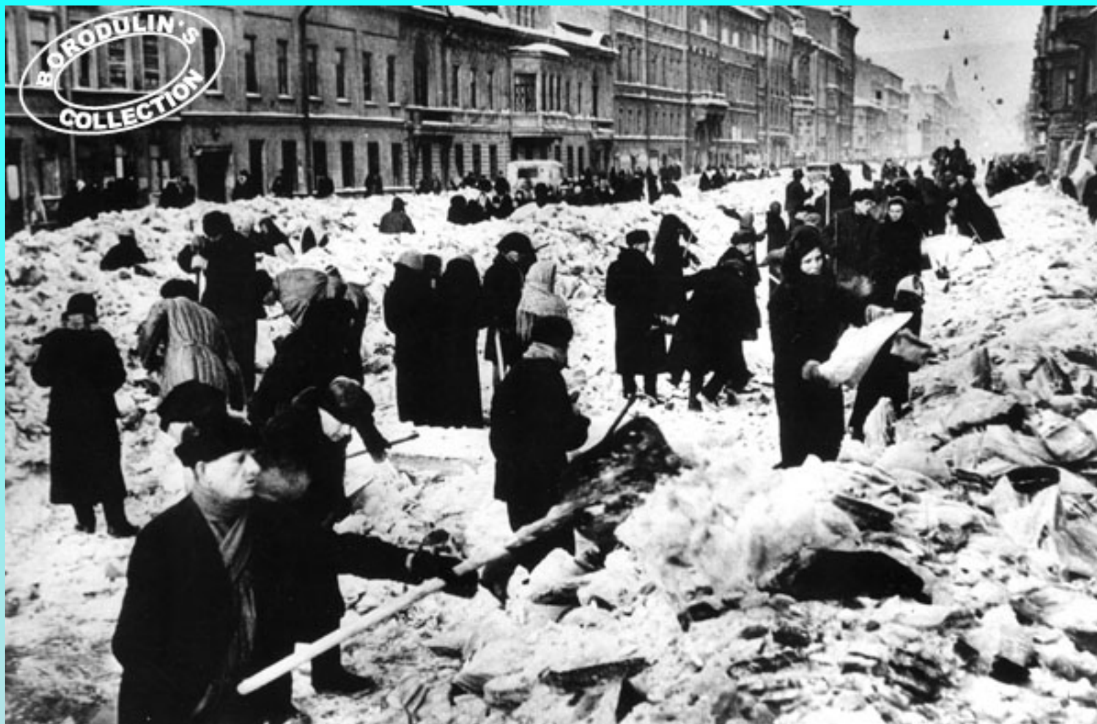
Восстановление Невского проспекта.
