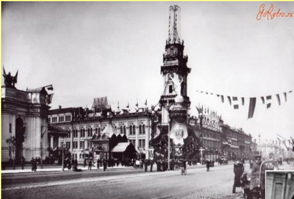
Здание Городской Думы (Невский, 33)
